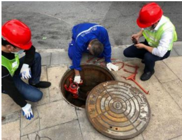
佛山燃气公司抢修人员现场排查
